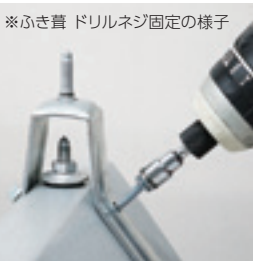
※ふき葺 ドリルネジ固定の様子
